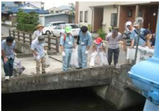
山室さん宅前水路の状況も見ました
